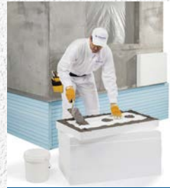
Wärmedämmung (WDVS)
