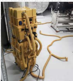
Bautrocknung
